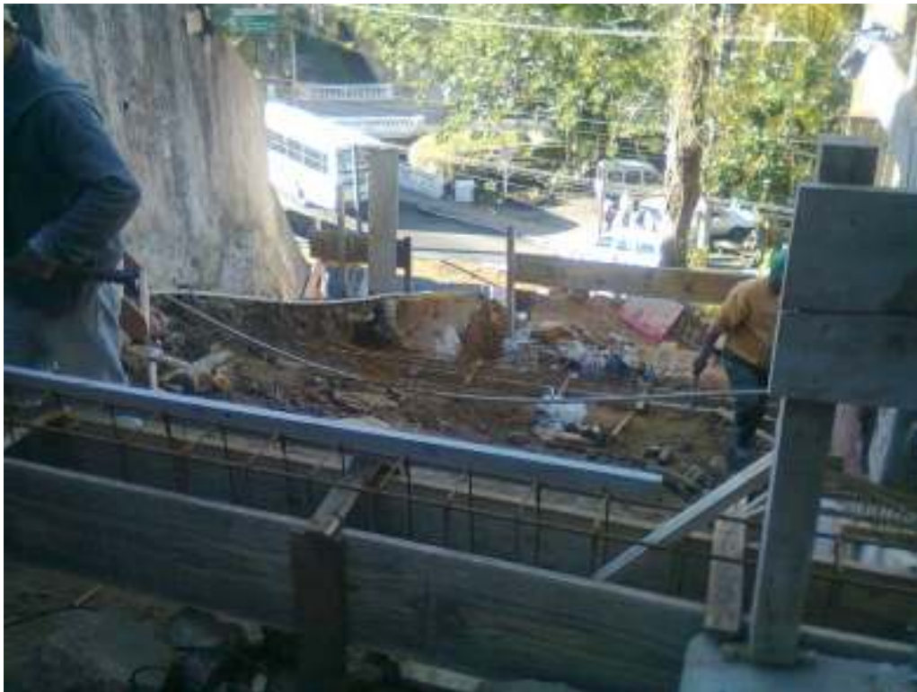
6) Vista da escada de acesso em execução
