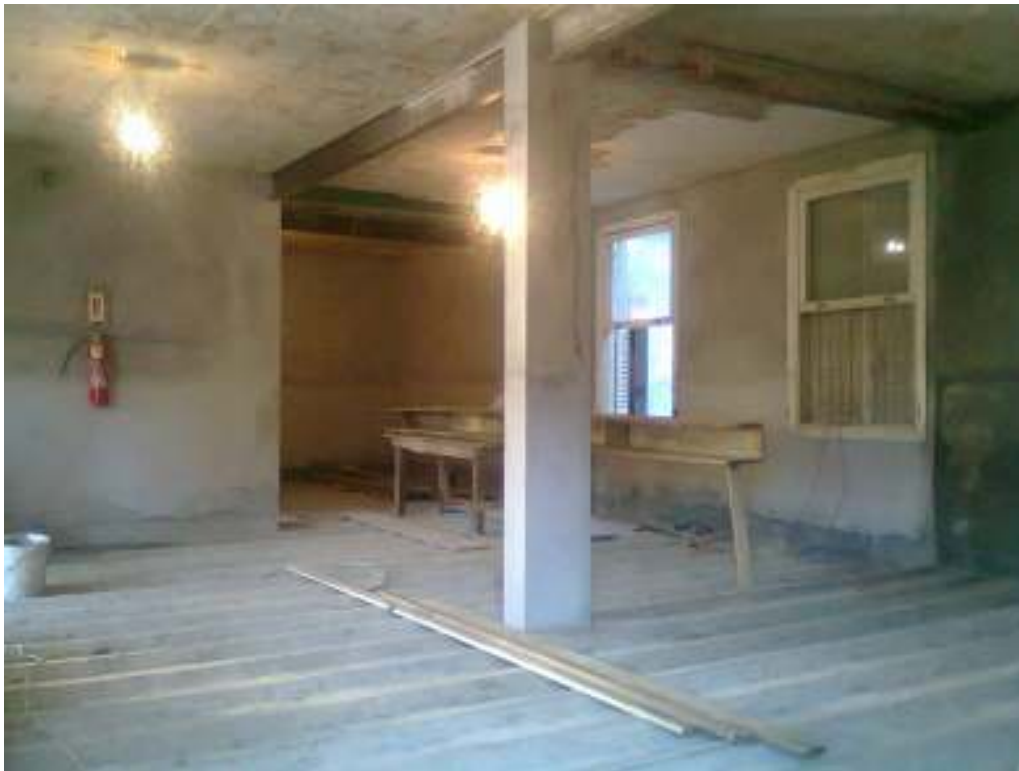
3) Vistas do salão com a demolição da parede da antiga cozinha.
